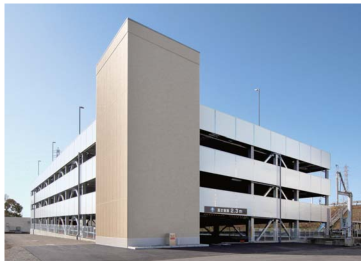
立体駐車場棟
