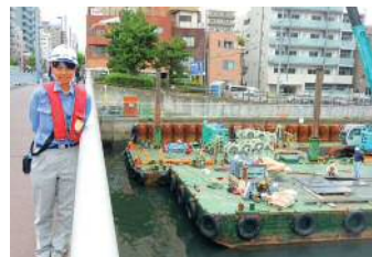
入江沙耶佳さんが担当している小名木川護岸耐震補強工事(平成30年3月に完成予定)
